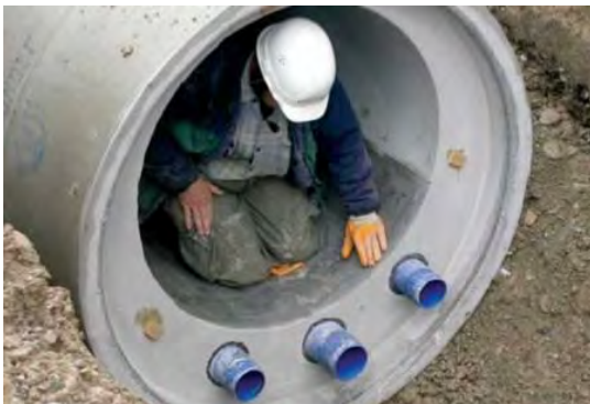
Canalisation préfabriquée avec échangeur de chaleur intégré (Guide pour les maîtres d'ouvrages et les communes, OFEN)
